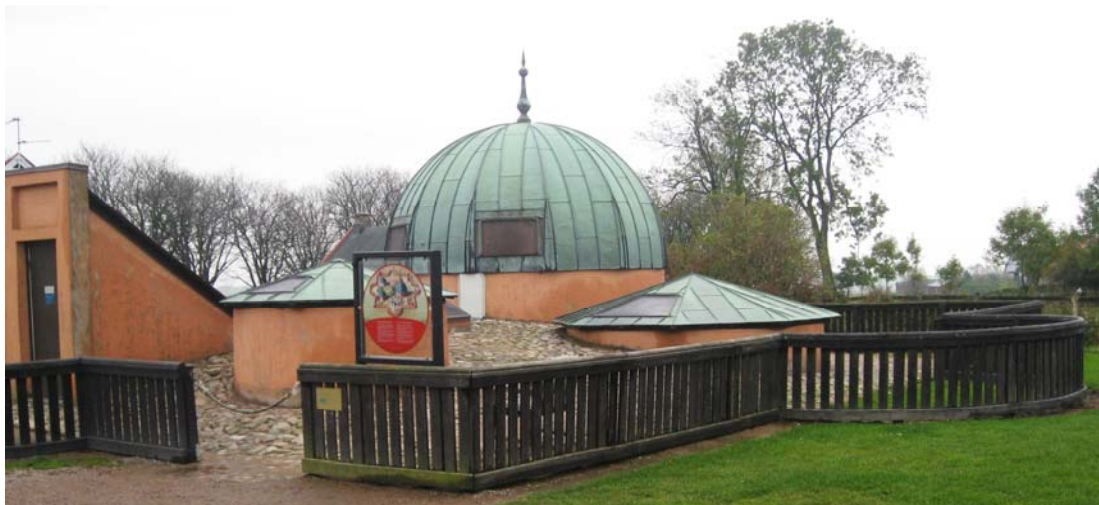
Реконструированное здание подземной обсерватории. Фото автора.
